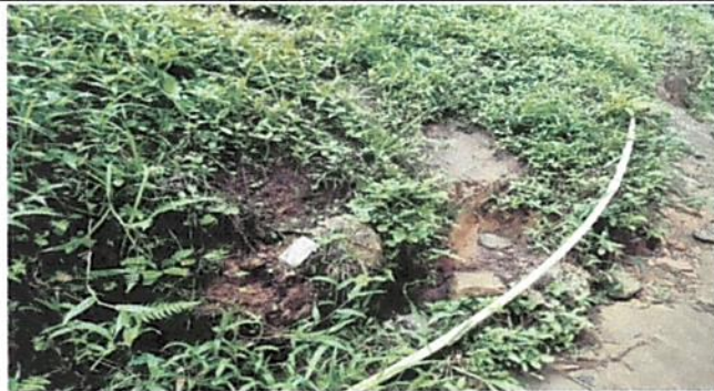
Foto 1: Cambio de tubería
