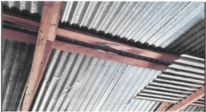
Foto 10: Cambio de madera por estructura metálica
